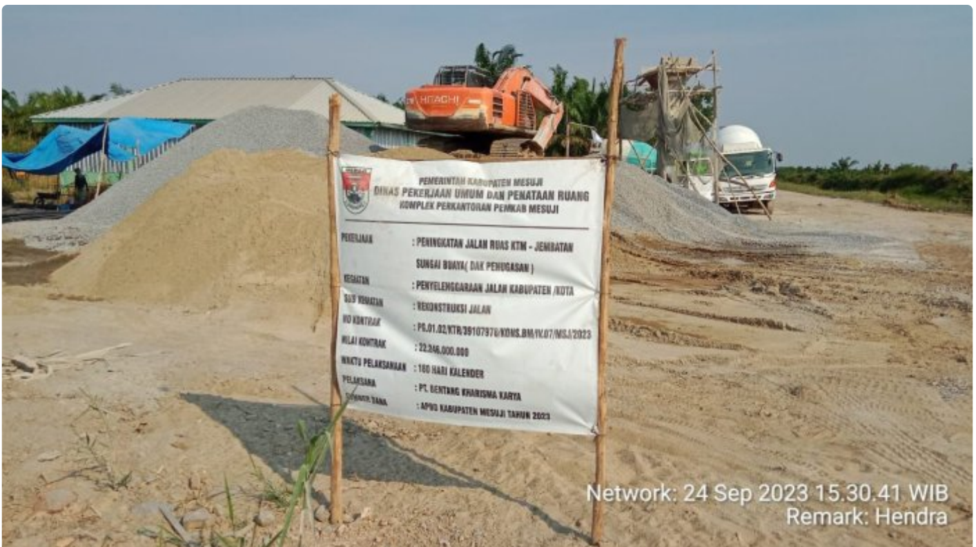
Pekerjaan rigit beton pada ruas penangkis Sungai Buaya Mesuji
